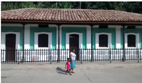
Figura 1: Fachada de la casa de ingenieros del conjunto férreo de Suarez, después de su restauración. Imagen del autor 2016.
