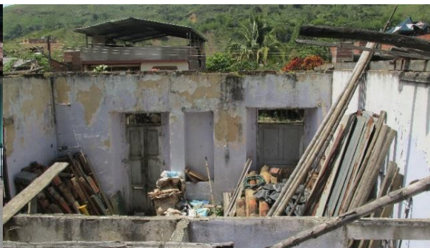
Figura 2: Estado antes de las obras de restauración del edificio central de conjunto férreo de Suarez. Imagen del Autor, Año 2014.
