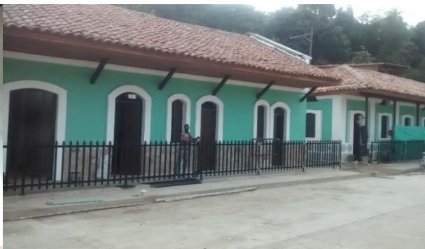
Figura 4: Fachadas edificio de ingenieros y del central después de su restauración. Imagen del Autor. Año 2016.
