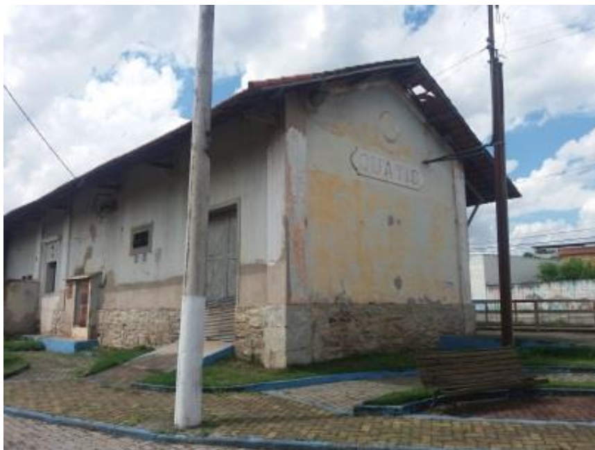
Figura 1: Estação de trem desativada – Quatis Fonte: Foto da primeira autora (2016)
