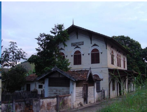
Figura 2: Estação de Engenheiro Passos. Fonte: Arquivo da Pesquisa.
